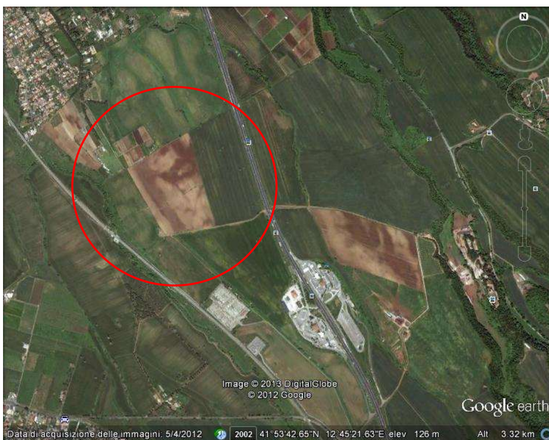
Vista aerea dell'area di intervento
